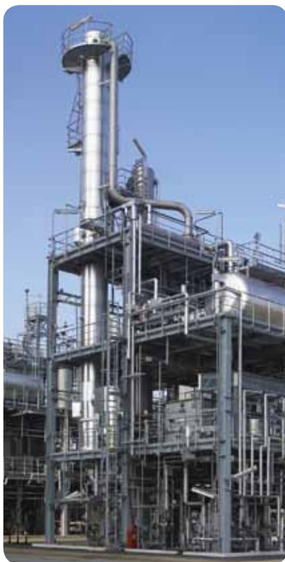
Ochrona stalowych konstrukcji
