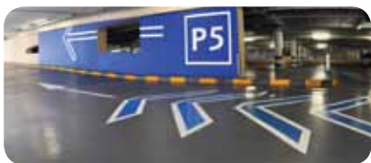
Wykonanie oznakowania na posadzce
