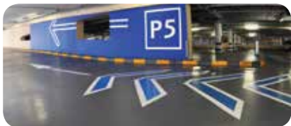
Wykonanie oznakowania na posadzce
