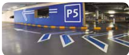
Wykonanie oznakowania na posadzce
